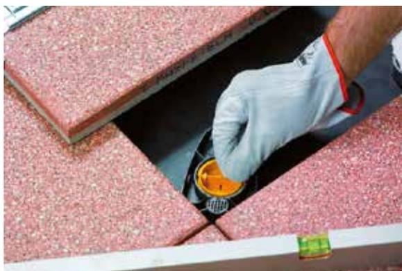
Ogni rotazione della vite di 90° corrisponde ad un aumento di spessore pari a 1 mm.
